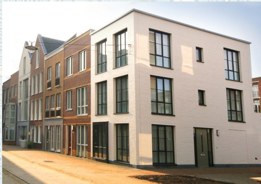
... grondgebonden hoekwoning met dakterras...
