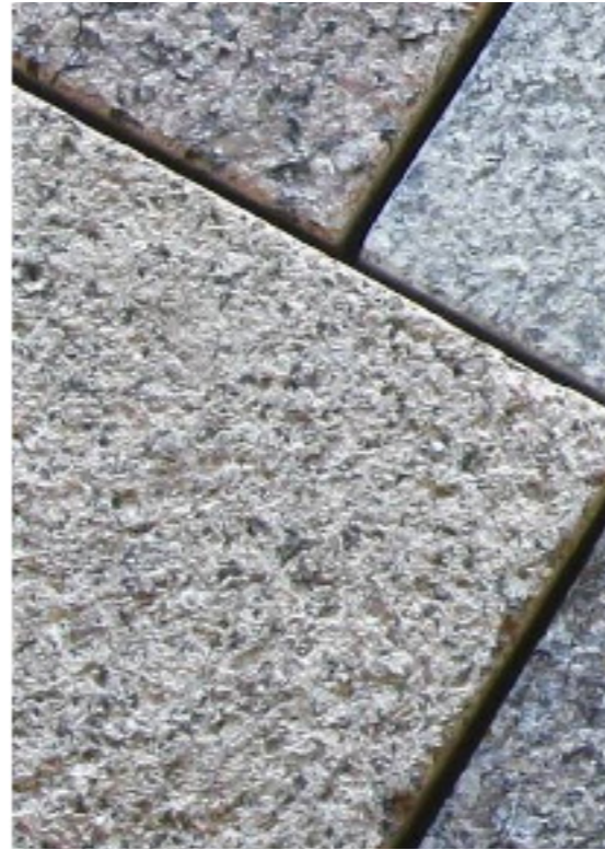
Natuursteen Graniet in genuanceerde kleuren grijs/bruin Scandinavian mix, Van de Ban Afmetingen: gezaagde tegels 20x14x5 Bovenkant gevlamd, overige zijden gezaagd Halfsteensverband
