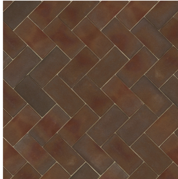
Woonstraten, rijbaan: Gebakken klinkers, kf padova keperverband
