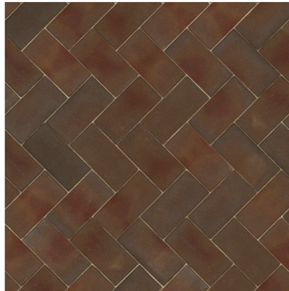
Woonstraten, rijbaan: Gebakken klinkers, kf padova keperverband
