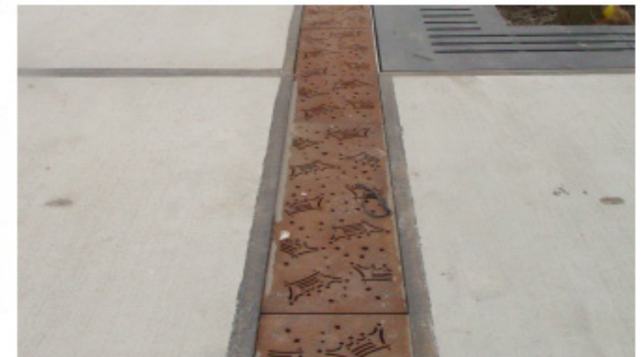
Voorbeeld roostergoot met eigen ontwerp, hier van winkelcentrum 'De Baronie' in Alphen aan den Rijn
