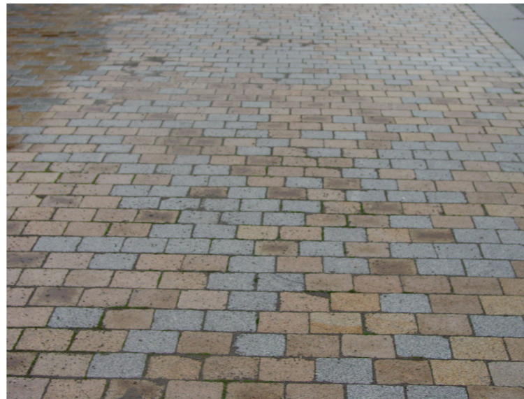
Voorstel bijzondere bestrating: vlak gezaagde natuursteenkeien
