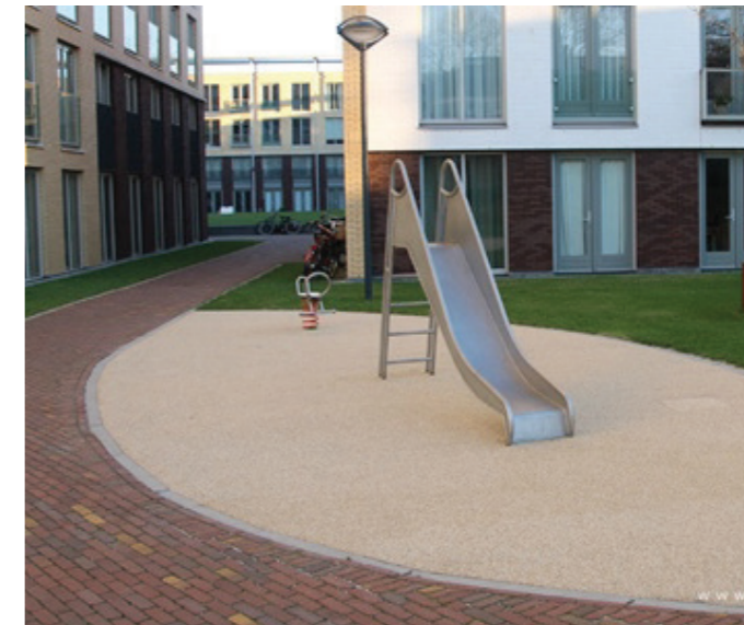
Valdempende ondergrond: EPDM rubbervloer zandkleurig
